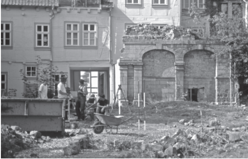
l: Site of the destroyed synagogue in Halberstadt, students during the excavation (2005)/Grundstück der zerstörten Synagoge in Halberstadt, Studenten bei der Ausgrabung (2005).
